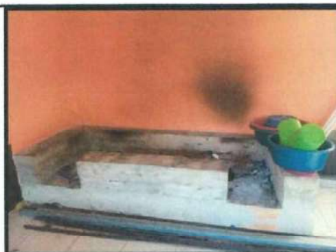
Foto 16: REPARACIÓN DE COCINA: Instalación de parrilla del polletón de 2.00 mts x 0.7 cms.
