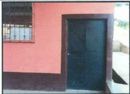
Foto 1: PUERTAS DE METAL: Mantenimiento a estructura (lijado, cepillado, aplicación de pintura)
