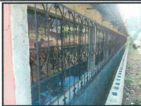
Foto 4: BALCONES: Mantenimiento a balcones de metal (lijado y pintado)
