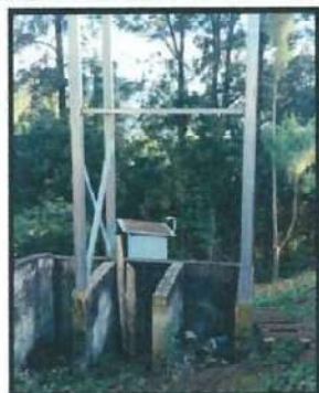
Foto 15: Mejoramiento de cubierta bomba de agua.
