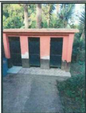
Foto 3: Instalación puertas de baños.
