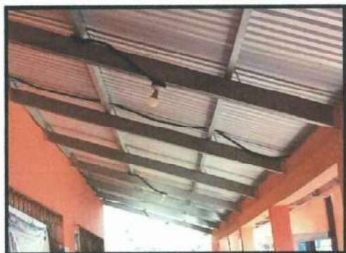
Foto 13: Reparación sistema eléctrico principal
