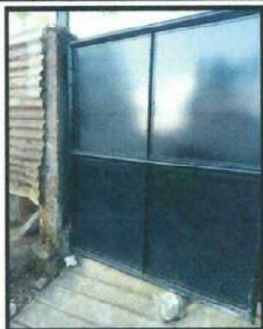
Foto 7: MANTENIMIENTO A PORTON: Reforzamiento de la base del portón.
