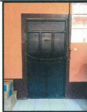
Foto 2: Sustitución de chapas en mal estado.
