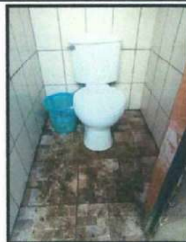
Foto 8: REPARACIÓN RED DE DRENAJE. Sustitución de tubería PVC línea principal aguas negras.
